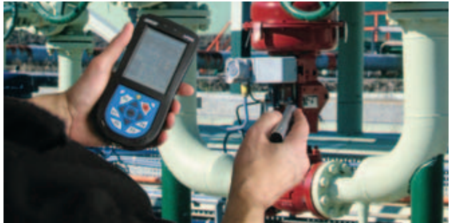
De onderhoudsgeschiedenis van een pomp aflezen van een transponder die is bevestigd op de behuizing.
